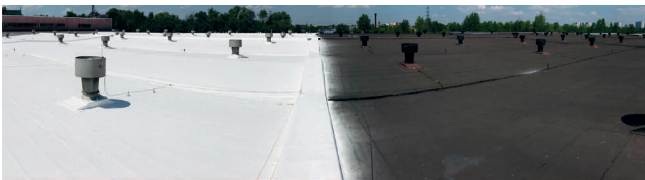
POMIAR TEMP. DACHU PRZY POMOCY KAMERY TERMOWIZYJNEJ
